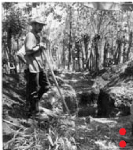
Nazareno: Erste Vorbereitungen zum Bau einer Biogasanlage
