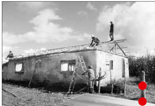
Beseitigung von Hurikanschäden
